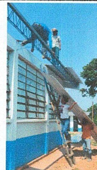
Foto 6: Instalacion de laminas troqueladas.
