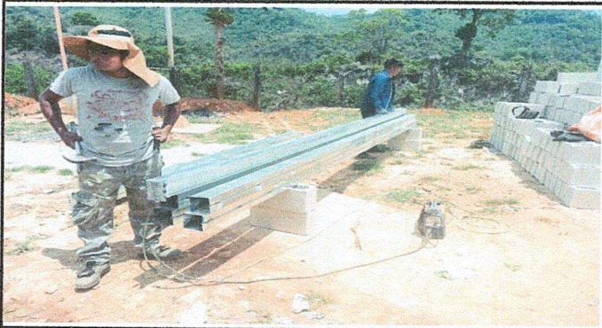
Foto 3: Preparacion de estructura metalica modulo I.
