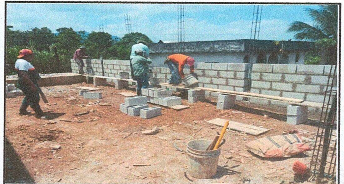
Foto 4: Rehabilitacion de Cocina.
